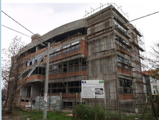
Nova zgrada Općine Srebrenik u izgradnji
