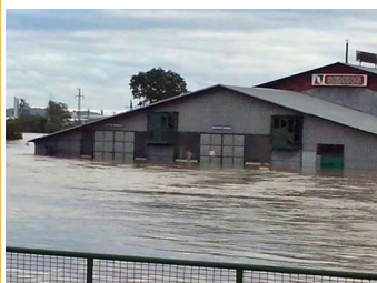
Poplavljena industrijska zona u Gračanici
