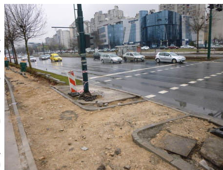
Radovi na izgradnji biciklističke staze
