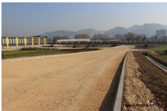
Izgradnja primarne saobraćajnice u Poslovnoj zoni "Misurići" Maglaj
