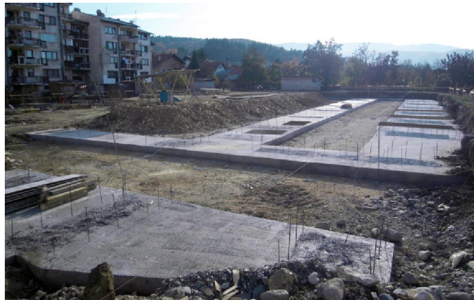
Slika 15: Sportska dvorana u izgradnji
